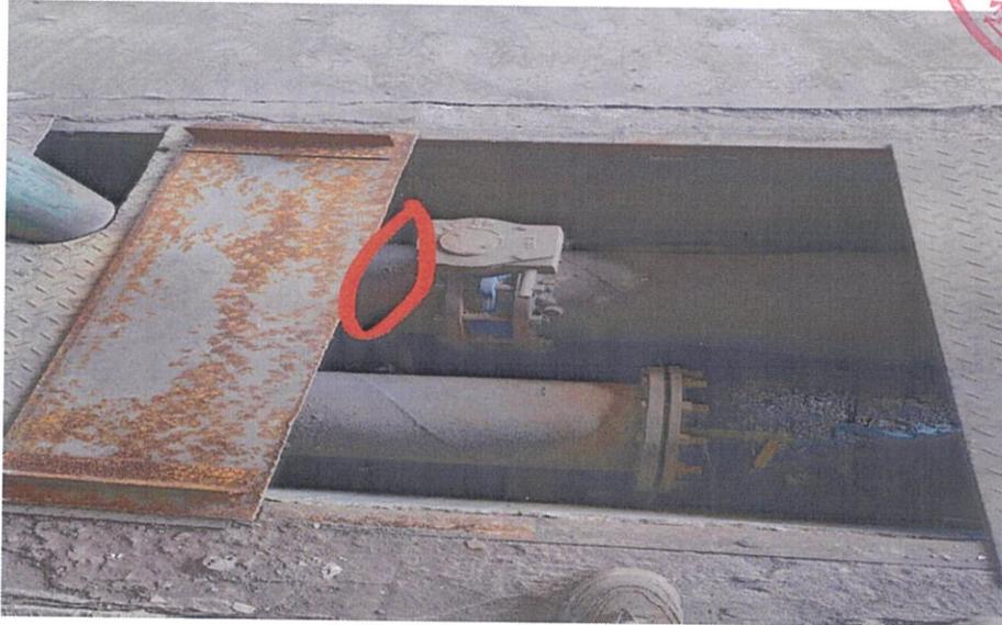
8. 冷却塔回水管与 2 万连接管：红色标记处为分离位置，标记右侧阀门及管道保留。
