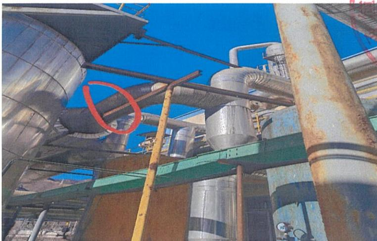
3. 氮气平衡器管路：红色标记位置为分离位置，标记右侧 720 大管道是与 2 万连通氮气管道保留。左侧为处置管道。
