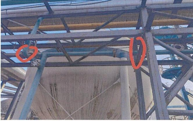
2. 氮气调压阀组：红册标记位置是分离位置，标记向上到管廊上氮气管道为处置管路。
