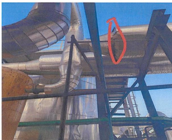
4. 厂房墙外到球罐管廊：管廊及顶部 2 根氧、氮气管道保留，其余管道为处置管道。
