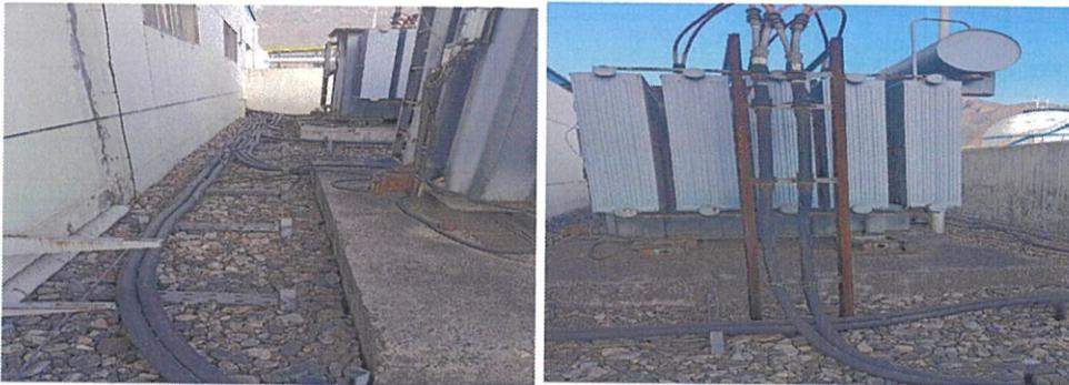
11、水泵房动力配电柜（含进出线电缆）（出线电缆由配电室低压柜 AA2 抽屉 G 至水泵房动力配电柜，进线电缆由 2 万水泵房配电室低压柜至水泵房动力配电柜）
